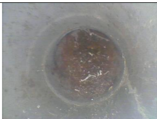
Cambio di direzione e di pendenza da verticale ad orizzontale.(BCC)
