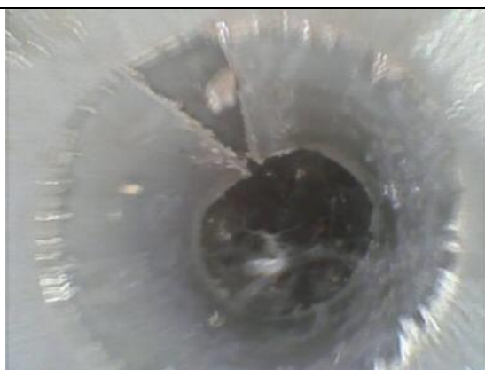
Tubazione deformata per essere inserita in un diametro inferiore.(BAA)
