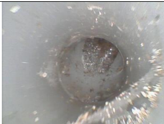
Cambio di direzione e di pendenza da verticale ad orizzontale.(BCC)
