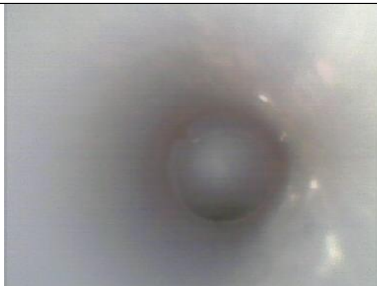
Cambio di direzione e di pendenza da orizzontale a verticale.(BCC)
