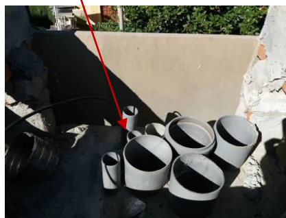
Cambio di direzione e di pendenza da verticale ad orizzontale.(BCC)
