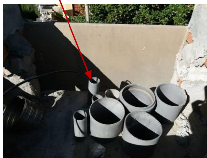
Tubazione deformata per essere inserita in un diametro inferiore.(BAA)
