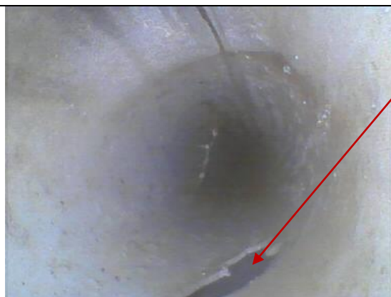
Rottura.(BAC)
